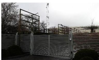
Celis bedrijfswoning Kraaiwinkelstraat met toegang bedrijvensite Hier staat ook een zendmast
