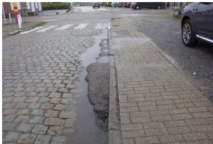
Figuur 41: Kasseiverharding op rijweg is soms verzakt, waardoor ook afwatering niet meer naar behoren functioneert; kasseiverharding op voetpaden soms moeilijk begaanbaar
