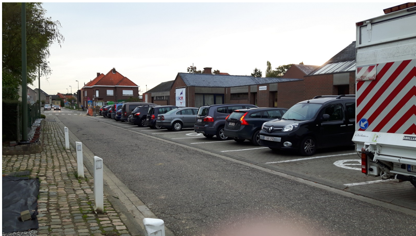
Figuur 48: Kerkplein noordelijke tak: voetpad in kasseien, asfalt en betonklinkers voor parkeerstrook
