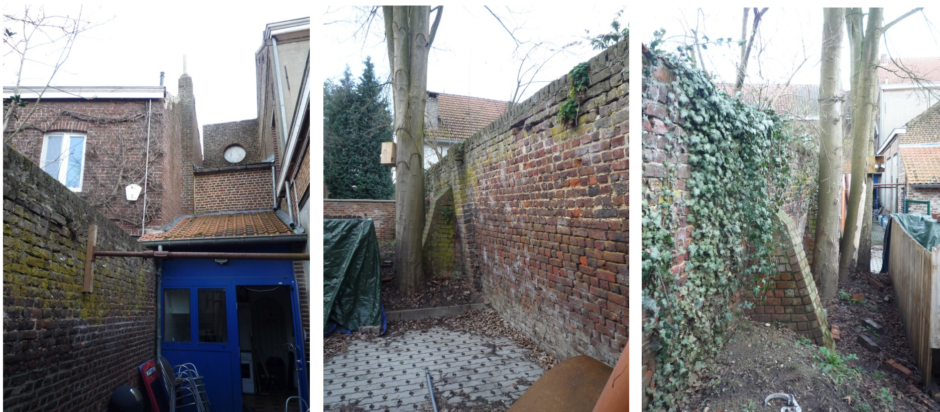
Figuur 33: Zicht op achteruitgang van het kloostergebouw en bijgebouw en tuinmuur van nr. 3
