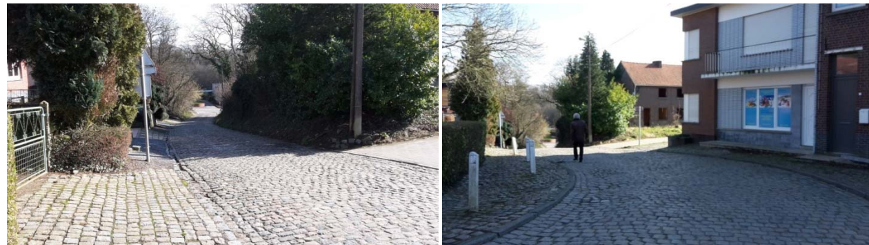
Figuur 39:foto's Kerkplein holle Weg: porfier kasseien (voetpaden in Tiense Kassei ( vanaf Schutterstraat)
